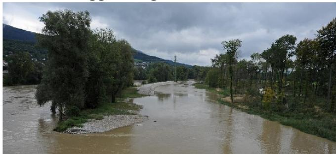
Als ökologische Ausgleichsmassnahme zum Bau der Staffeleggstrasse ist eine neue Weichholzaue entstanden. Dazu ist der 900 m lange Aaredamm zurückversetzt und ein neuer Seitenarm angelegt worden. Bei Hochwasser kann die Aare hier nun wieder ausufernd und flächig durch die Aue strömen – ideale Bedingungen für den Aufwuchs von Silberweiden.
